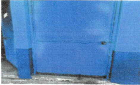
Foto1: MANTENIMIENTO A ESTRUCTURA A PUERTAS SERVICIOS SANITARIOS
