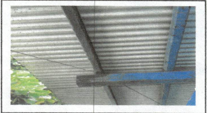
Foto 2: MANTENIMIENTO A SOPORTE DE ESTRUCTURA DE METAL
