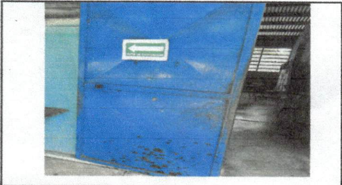
Foto 3: MANTENIMIENTO A PUERTAS
