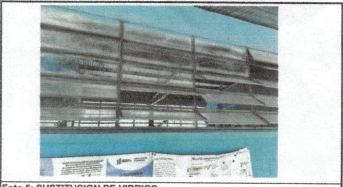
Foto 5: SUSTITUCION DE VIDRIOS
